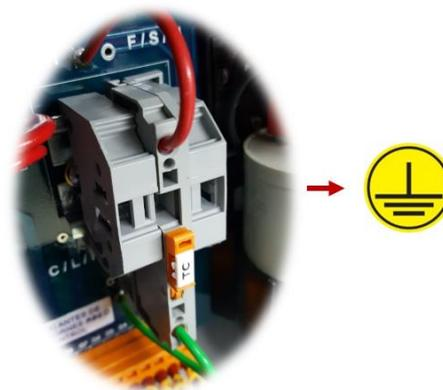
Figura 8: Procedimento para curto-circuitar o TC.
