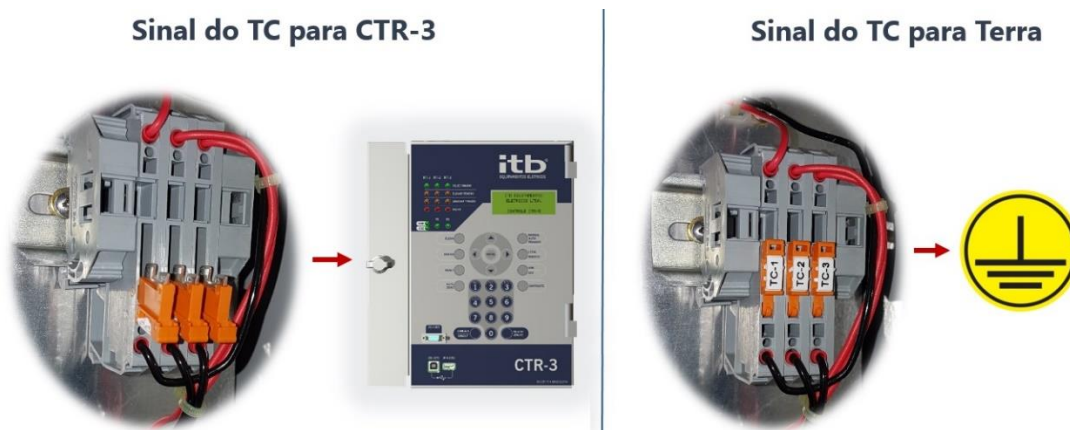
Figura 6: Procedimento de curto-circuitar os TCs.
